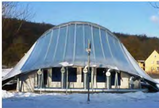
Abbildung 8: Muster-Eisbärenhaus mit textilen Solarkollektoren in Denkendorf
