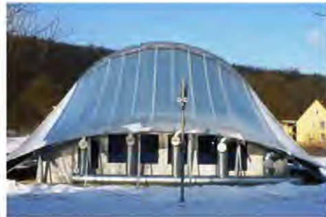
Abbildung 6: Muster-Eisbärhaus mit textilen Solarkollektoren in Denkendorf
