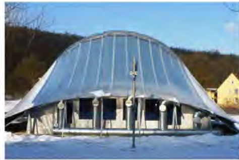
Abbildung 6: Muster-Eisbärhaus mit textilen Solarkollektoren in Denkendorf
