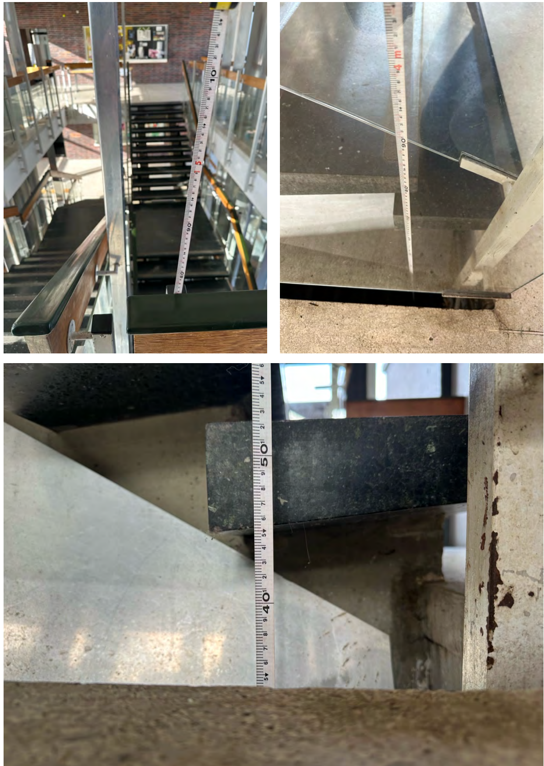
Abbildung 64: Höhenvermessung des Treppenhauses insgesamt (oben links) und pro Etage (oben rechts & unten)
