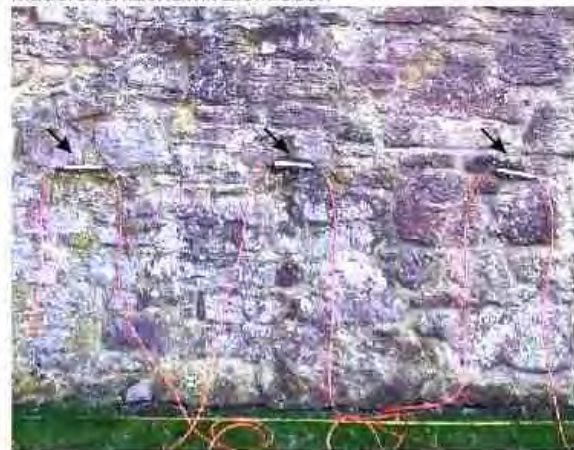
Foto Maueroberfläche mit Elektroden
