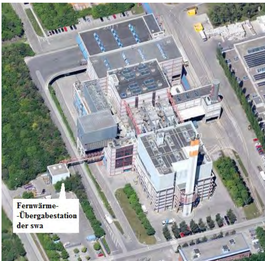
Abbildung 22: Luftbild des AVA-Hauptgebäudes (in dem das HKW untergebracht ist) und der Fernwärme-Übergabestation der Stadtwerke Augsburg (swa)
